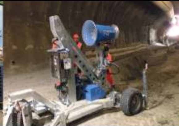
Realizzazione di gallerie
