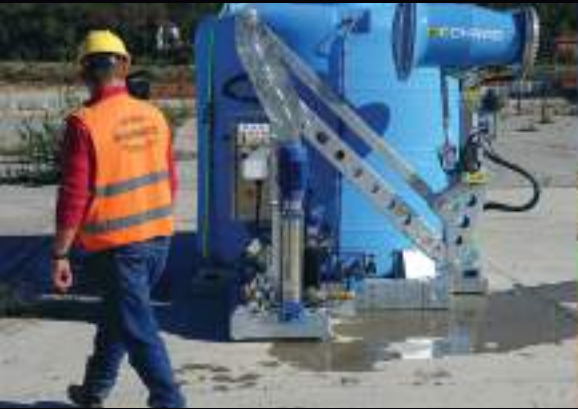
Bonifica del terreno
