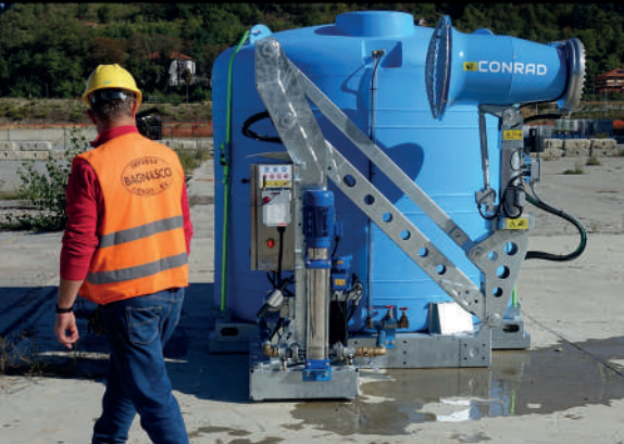
Bonifica del terreno
